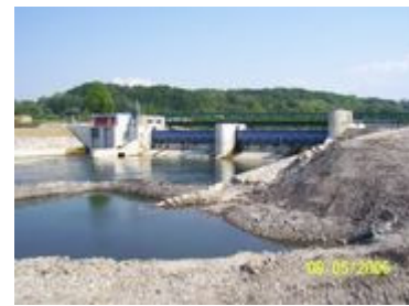
Kraftwerk in der Ybbs bei Kemmelbach
